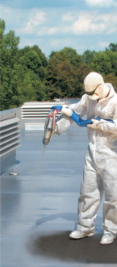
**POLIPROM 01** - эластичная высоко-реакционная система на основе полимочевины, предназначенная для нанесения бесшовного эластомерного гидроизоляционного покрытия на поверхность любых строительных конструкций.
