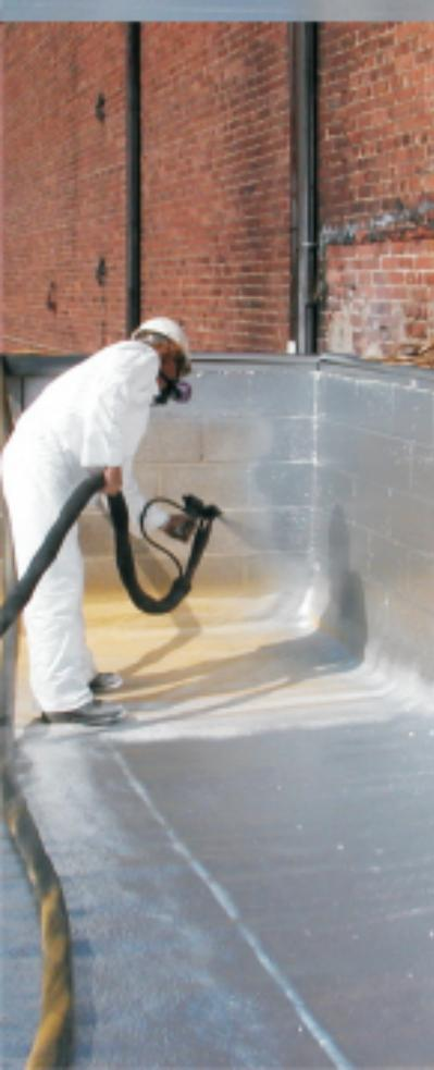
**POLIPROM 02** - жесткая высокореакционная система на основе полимочевины, предназначенная для нанесения бесшовного эластомерного покрытия с высокими изолирующими и антикоррозионными свойствами, повышенной стойкостью к абразивным нагрузкам.
