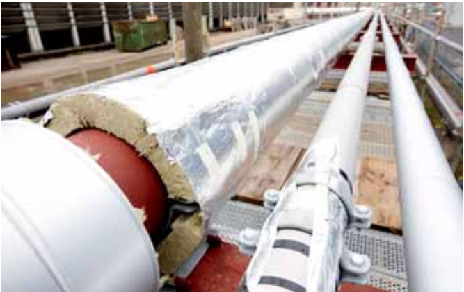
Теплоизоляция промышленного трубопровода Цилиндрами
