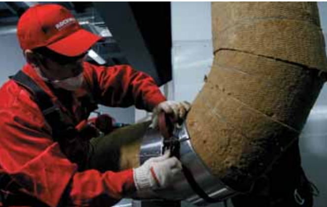
Теплоизоляция отвода трубопровода Цилиндрами
